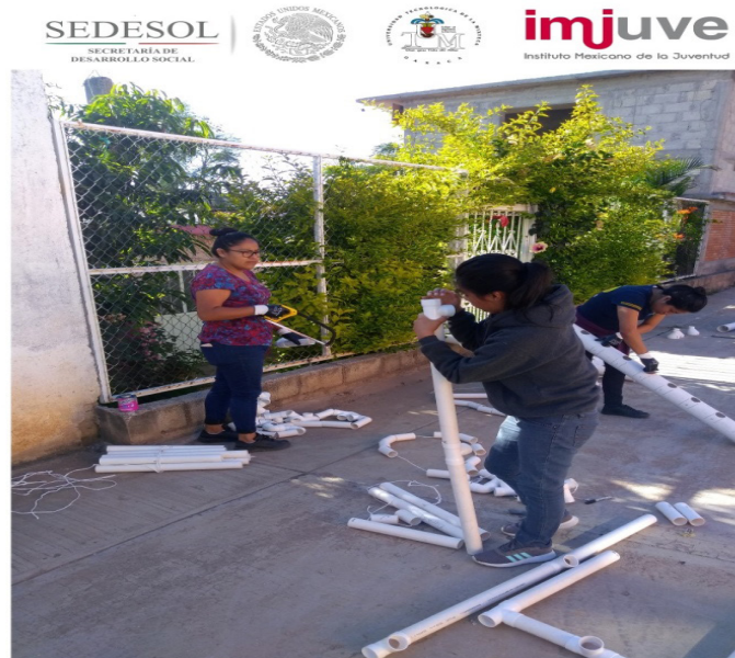
Figura 3. Armado de la estructuras de PVC para cultivos hidropónicos
