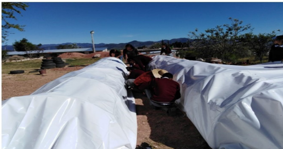
Construcción de estructuras para microtúneles en la Sec. Técnica 267.
